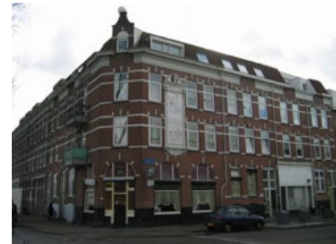
Café Arena, hoek Hilledijk - M. Steijnstraat
