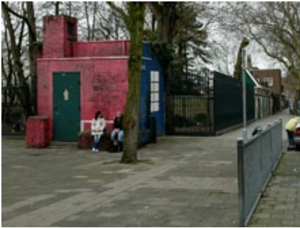
Hangplek rond de trafo
