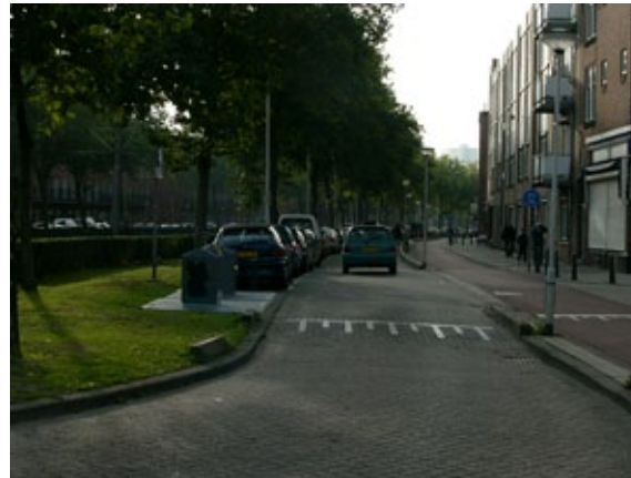
Bolle straatwand niet over de volle lengte te overzien
