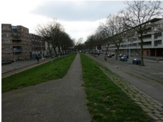
Overzicht vanaf verhoogd looppad op twee verschillende randen
