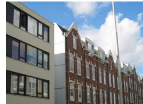
nieuwbouw en renovatie in de De la Reystraat
