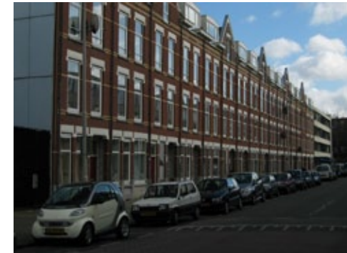
Renovatie in de Joh. Brandstraat
